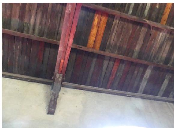
Détail des gîtes favorables sur le dessous de l'entrai et vue des voliges de sous toiture
